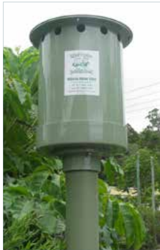
VF300 ON 100MM VENT POLE
